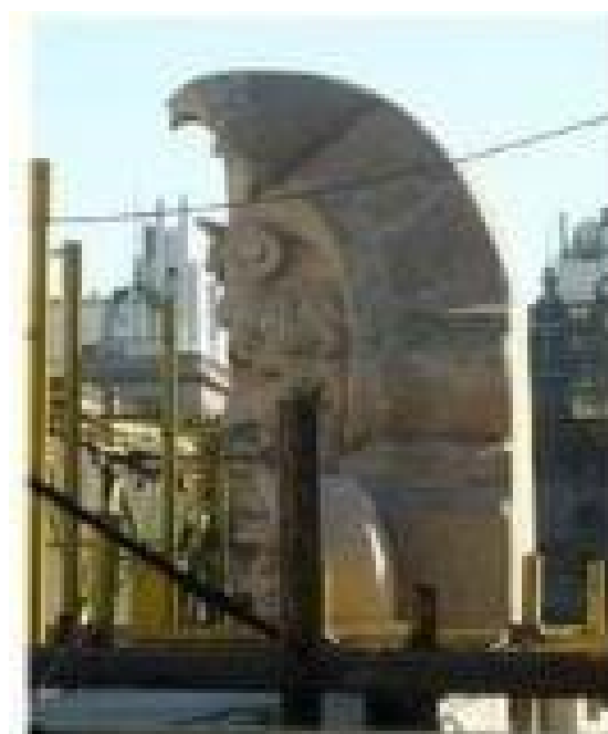
Colón en obras (1) © Maruxa Balifias
